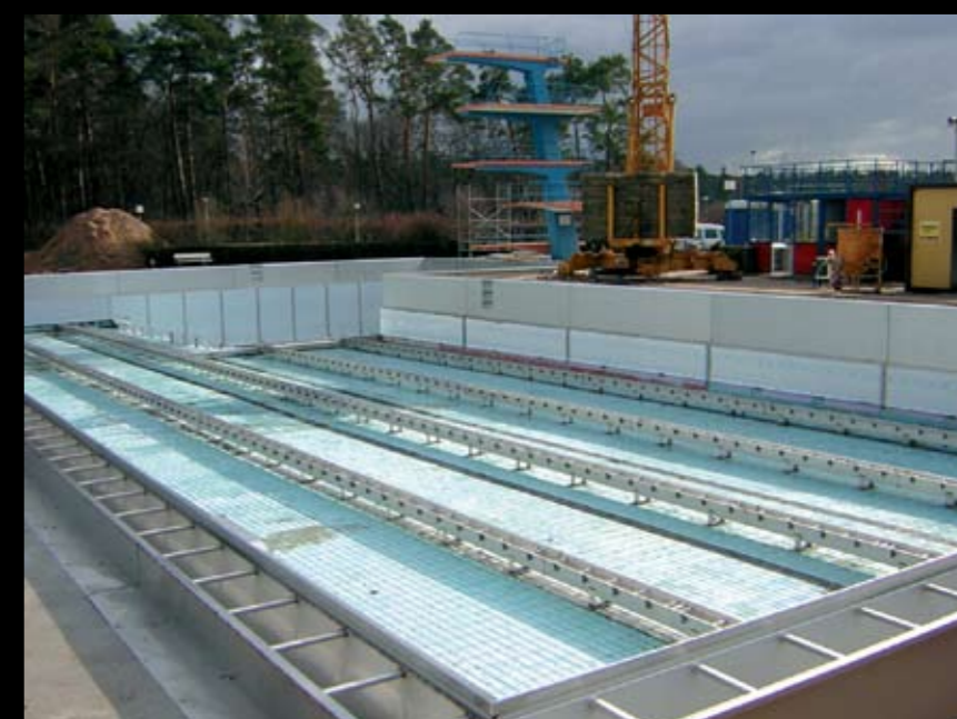
На фото: ↑ В бассейнах из нержавеющей стали чаще всего встречается ленточное расположение каналов подачи воды в основании бассейна
